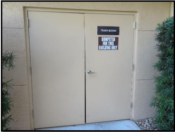
Trash room door
